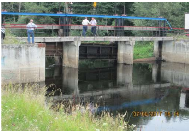
Рисунок 1 – Гидроузел на р. Лесная в д. Дружба
